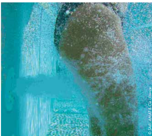
Wandebau Montage en paroi Wall installation
